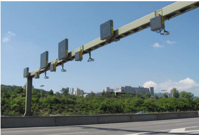
2 Signalquerschnitt mit Radarsystemen.
