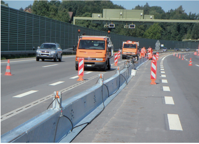
Mittelstreifenüberleitungssystem bei der Montage.
