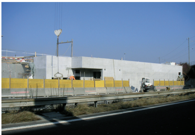
Zentrale Mühlebachstrasse im Rohbau. (Bilder: LBP AG)
