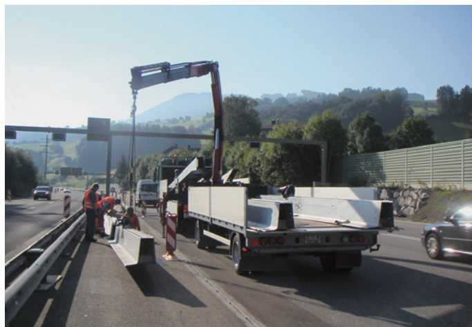
Montage der Leitschranken für das MÜLS.
