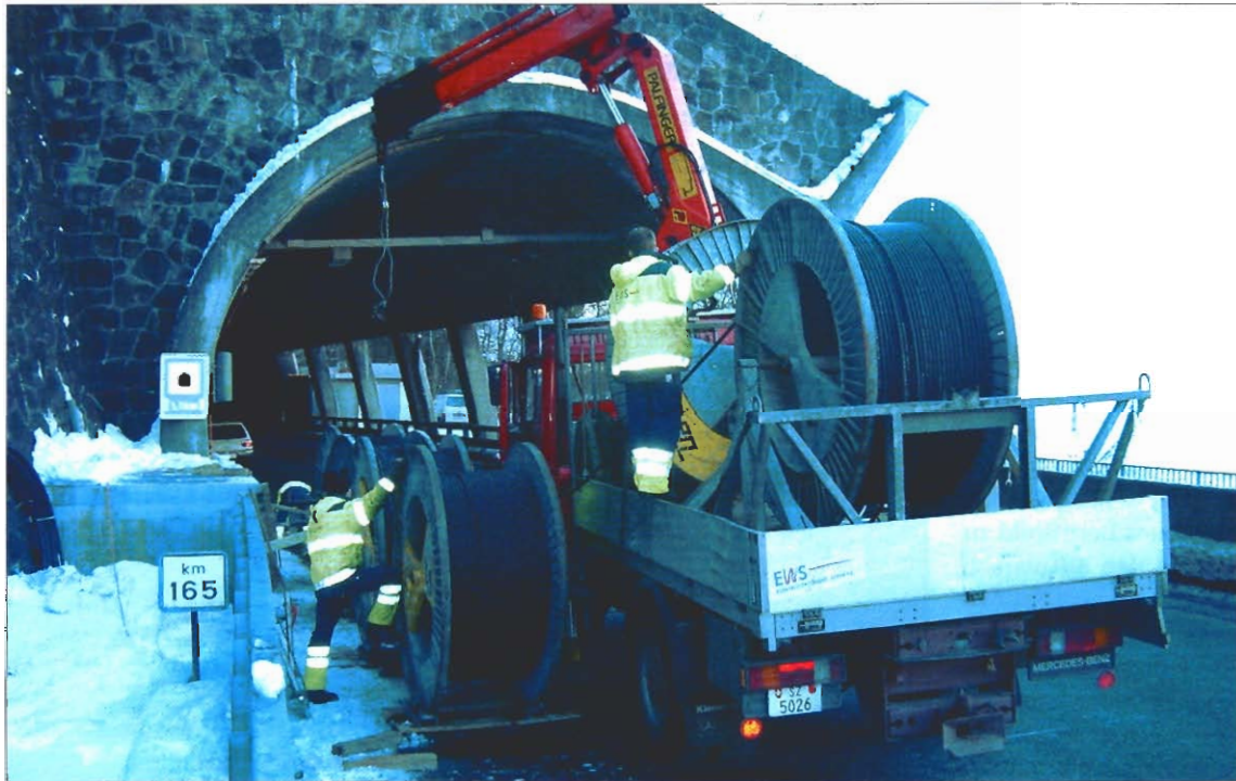
Kabelzug im Tunnel zwischen Murg und Weesen.
